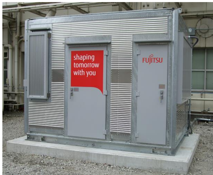
Figure 33 モジュール型データセンタの外観
